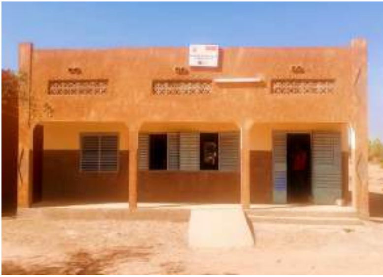
Une salle de classe construite à Diapangou (Région de l'Est)
