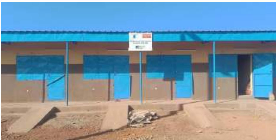
07 boutiques de rue construites au marché du secteur 1 de Ouahigouya au profit des commerçants et des PDI (Région du Nord)
