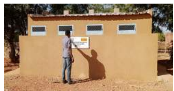
01 bloc de 4 latrines réalisées à la garderie communal de Poa (Région du Centre-Ouest)
