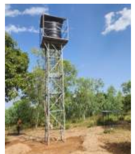
Une mini adduction d'eau potable réalisée au profit du centre des aveugles et malvoyants AZAMB de Koudougou (Région du Centre-Ouest)
