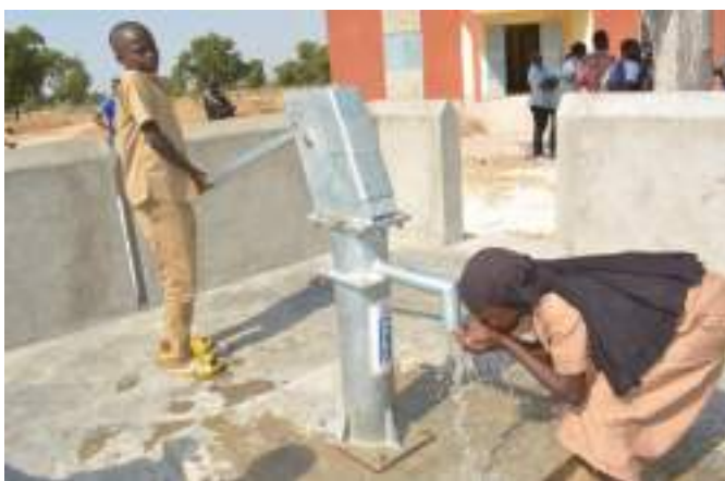
Un forage muni d'une PMH réalisée au CEG de Tita (Pouni, Région du Centre-Ouest)
