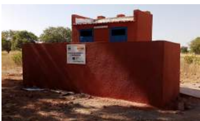
01 bloc de 02 latrines réalisées au centre médical de Pouni (Région du Centre-Ouest)
