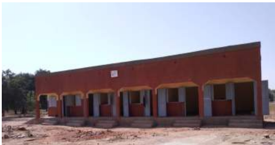
Six (06) boutiques de rue réalisées à la gare routière de Kordié, région du Centre-Ouest (projet d'aménagement d'une gare routière)
