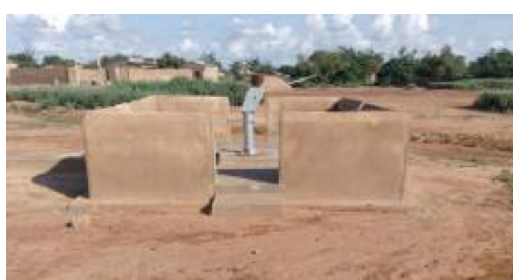
Un forage positif réalisé à Korindiaka, à Piéla
