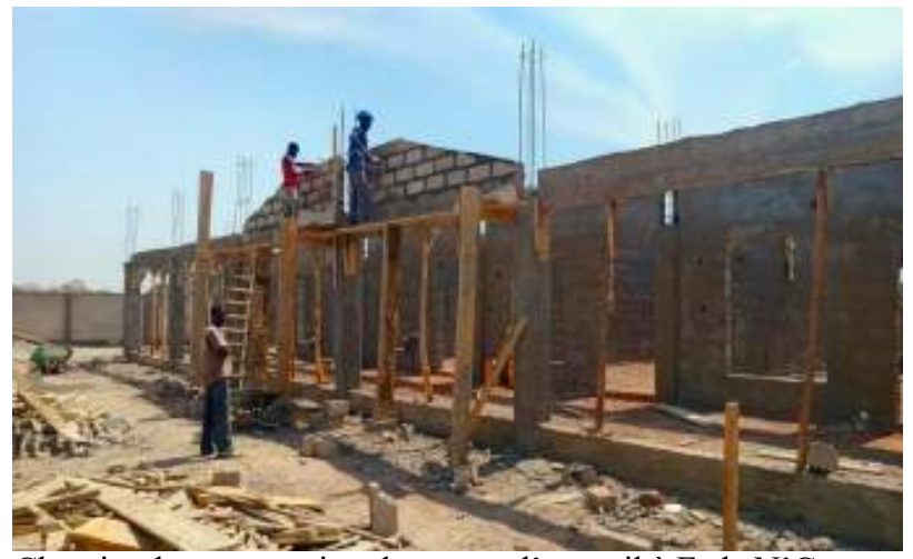
Chantier de construction du centre d'accueil à Fada N'Gourma au profit des élèves et étudiants PDI, projet d'inter-collectivités
