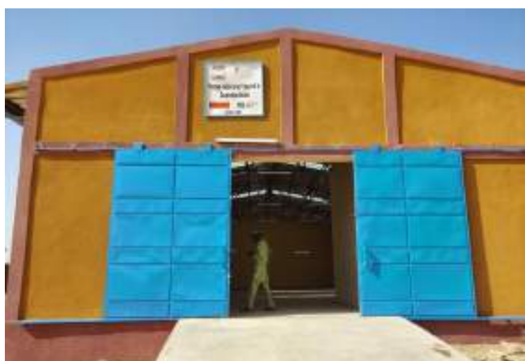
Un magasin de 100 tonnes réalisé au profit de la commune de Tangaye
