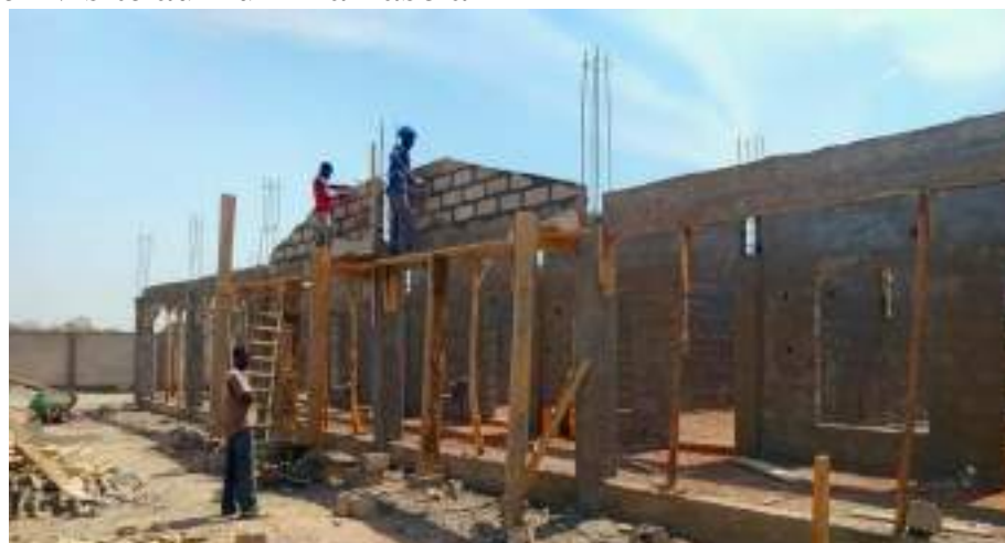
Les acteurs sont à pied d'œuvre pour la réalisation de l'infrastructure
