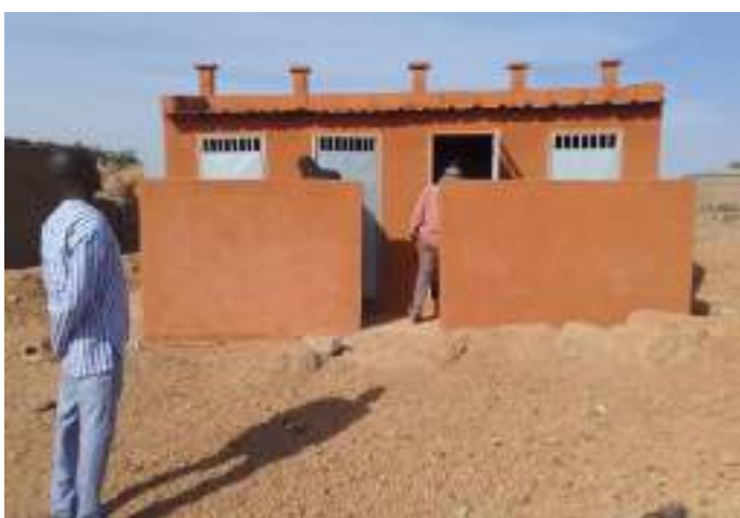
Un bloc de latrine de quatre (4) postes réalisée à Matiacoali (PAI 2023)
